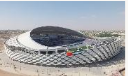
Al Ain Stadium (UAE)
