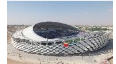
Al Ain Stadium (UAE)
